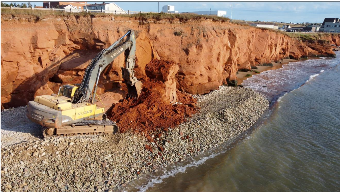
Figure 7 : Construction de la recharge de plage de Cap-aux-Meules
