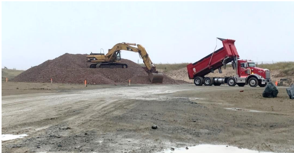
Figure 8 : Déchargement de matériel granulaire résiduel
