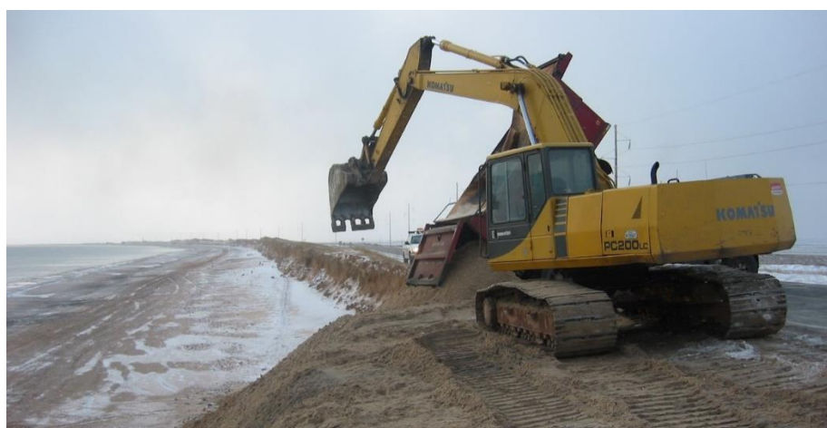
Figure 6 : Travaux de protection de la route 199 à Pointe-aux-Loups (© MTMD)
